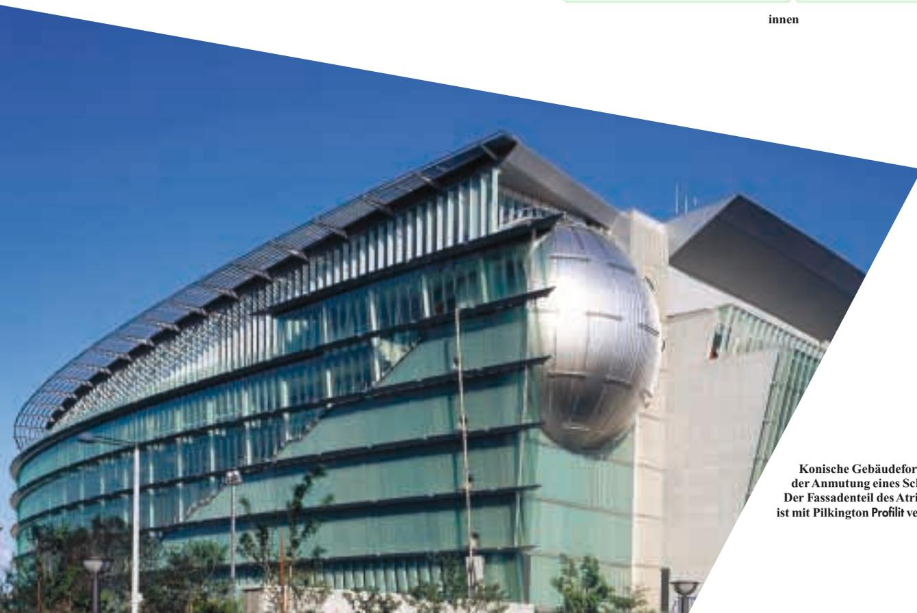
Konische Gebäudeform mit der Anmutung eines Schiffs: Der Fassadenteil des Atriums ist mit Pilkington Profilit verglast.
