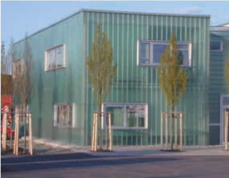
Der Büroklubus ist an den drei außenliegenden Fassadenseiten nahezu vollständig mit einer transluzenten Fassade aus Pilkington Profilit ausgestattet.
